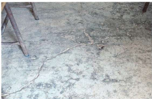
CAMBIO DE PISO
