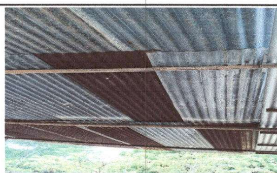
SUSTITUCIÓN DE LAMINA POR LAMINA TROQUELADA CALIBRE 26 Y SUSTITUCIÓN DE SOPORTES Y ESTRUCTURA DE METAL
